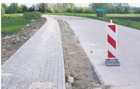
Modernizacja drogi w Kamieniu-Kolonii
