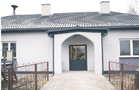
Wyremontowana świetlica w Ignatowie-Kolonii
